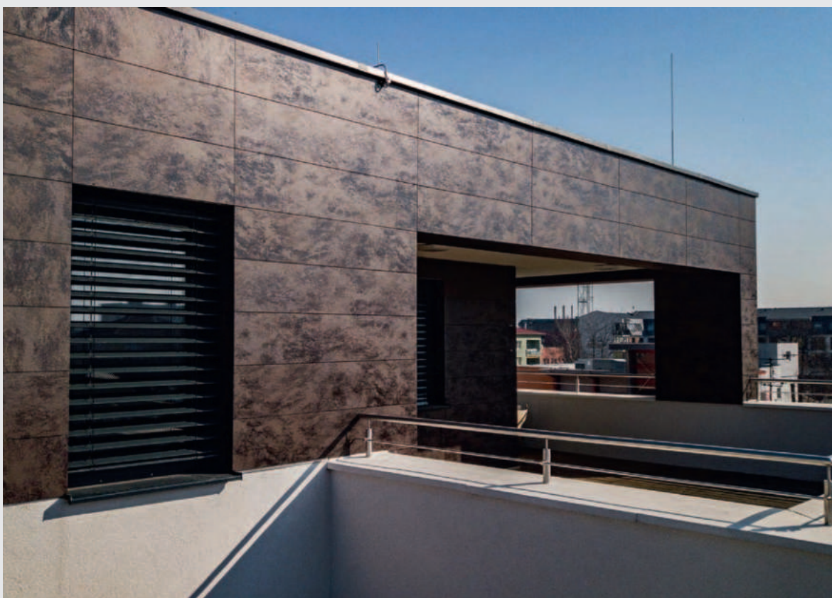
Dunajská Streda / Slovensko Apartmánový dom, lepenie na odvetrávaný systém.
